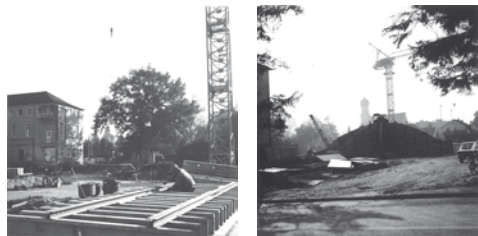
Die Bauphase im Jahre 1977
