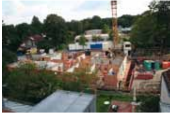
Neubau im Sommer 2006
