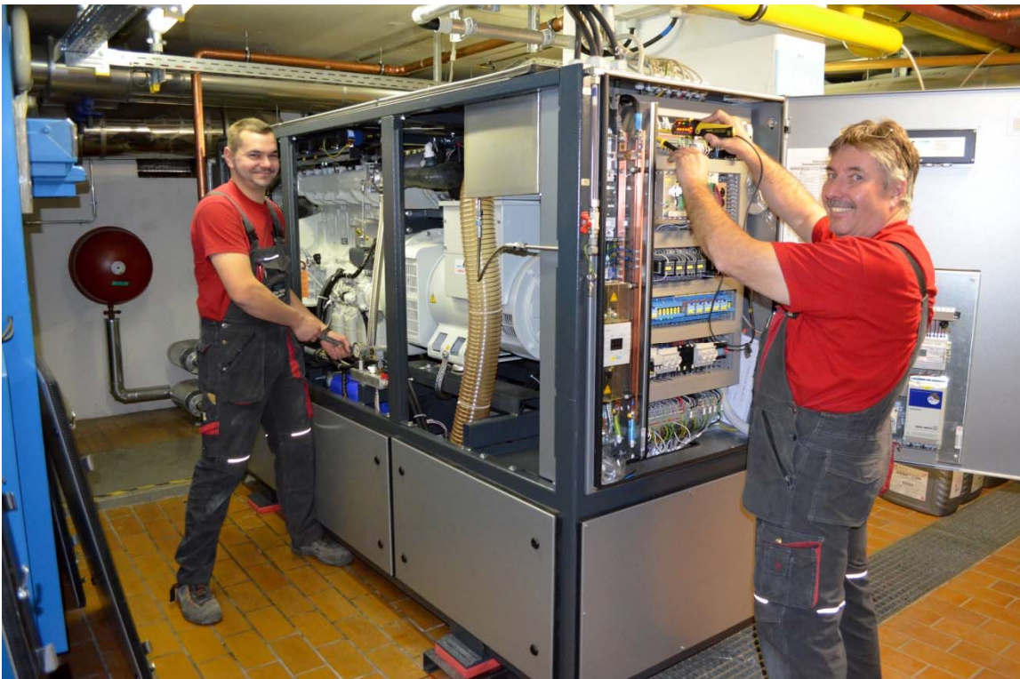
mit dem Aufbau des neuen BHKW beschäftigt: Haustechniker Willi Sailer (links) und Helmut Putzlocher
